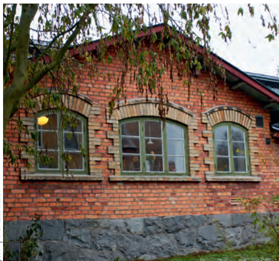
Beckomberga | karaktäristisk byggnad
