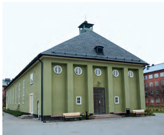
Beckomberga | Samlingssalen - karaktäristisk byggnad
