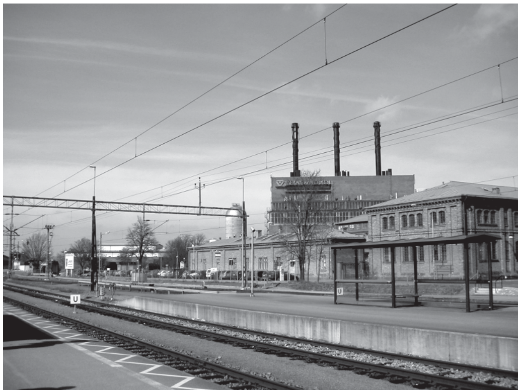
Stationsområdet. S:s station förlades norr om den gamla staden. Vy mot norr och Tornby industriområde.
