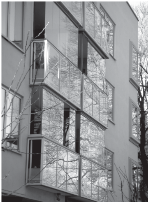
Detalj – inglasade balkonger. Inglasningen har de boende själva låtit utföra.
