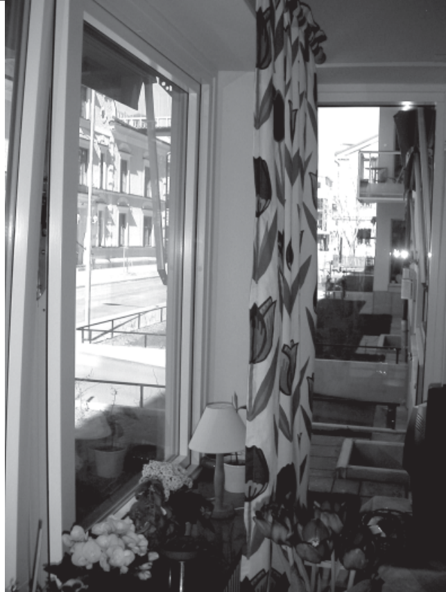
Detalj vid fönster. Djup fönsterbänk av sten. Nisch för radiatorn. Platsmålade sockellister som är gerade i hörnen.
