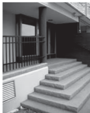
Entré mot Linnégatan. Trappa av sten och arkad med pelare. Port i ek.
