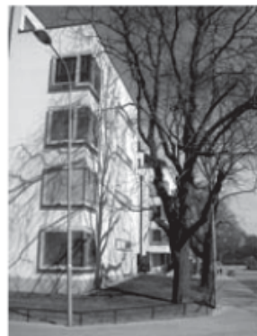
Fönster över hörn
