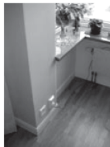
Omsorg om material och detaljer, Trægolv, sockellister i trä med gerade hörn, djup fönsternisch med fönsterbänk av sten.
