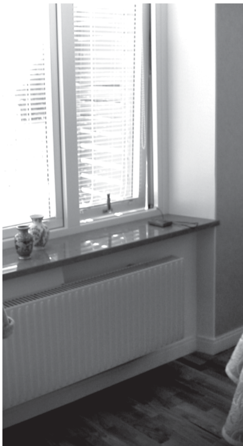
Detalj fönster. Ekgolv, infälld radiator i nisch, plattsmålad sockel-lister, snedfasad vägg i fönstersmygen, djup fönsterbänk i sten.
