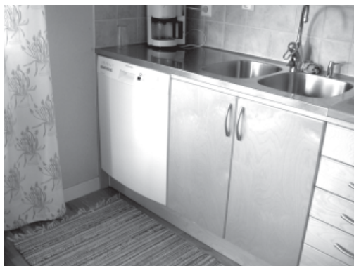
Diskmaskinen når väggen. Det är svårt att klara mötet mellan diskhantering och tapet.
