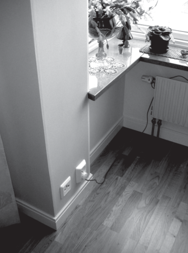
Detalj vid burspråket i köket. Djup fönsterbänk av sten kragar ut över radiatoren. Trägolvt.
