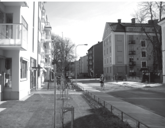
Skivhuset Repslagaregatan 41/43. Entrén vetter ut mot gaturummet. En entrégång sträcker sig över förgårdsmarken.
