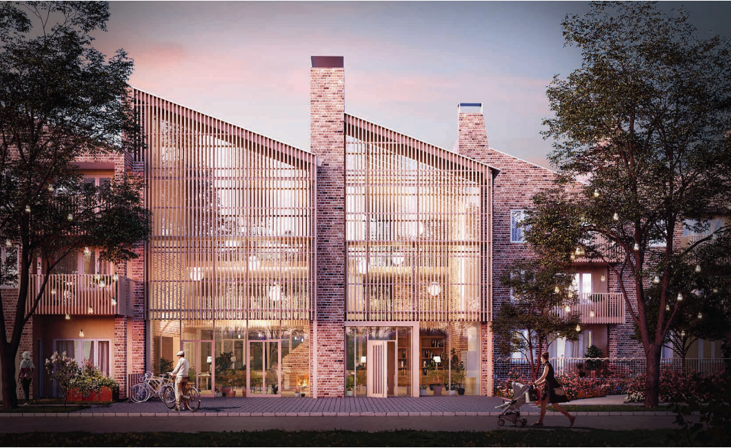
Husets fasad är i robust tegel och trä. Den gemensamma entrén är en mötesplats med både vinterträdgård och glasveranda.
