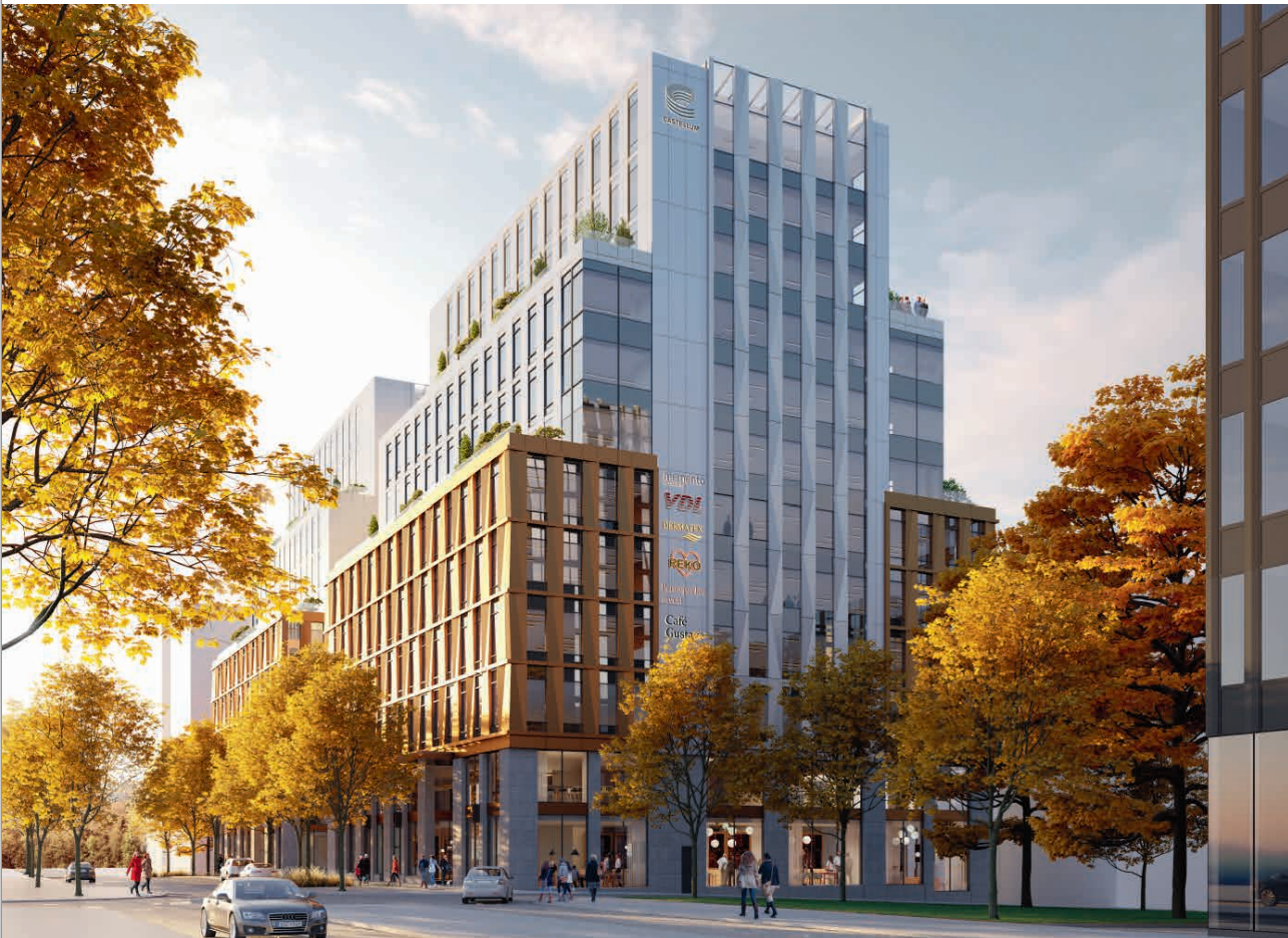
Fasaderna är i vackert bronsfärgad och en ljusare metall. På taken finns flera gröna terrasser.
