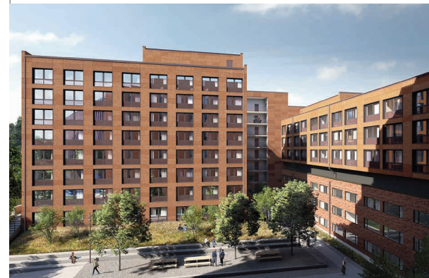
Den ursprungliga gården ritades av landskapsarkitekt Gunnar Martinsson. I samarbete med Land Arkitektur har vi byggt vidare i hans anda av enkel formgivning.
