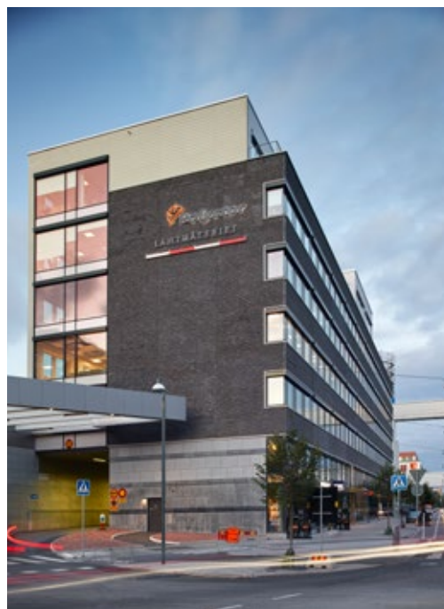
Kontorshuset Sthlm 03 ligger med ena fasaden mot Hammarby Allé. Den är i stadsmässigt tegel. I botten finns butiker och café för alla.
